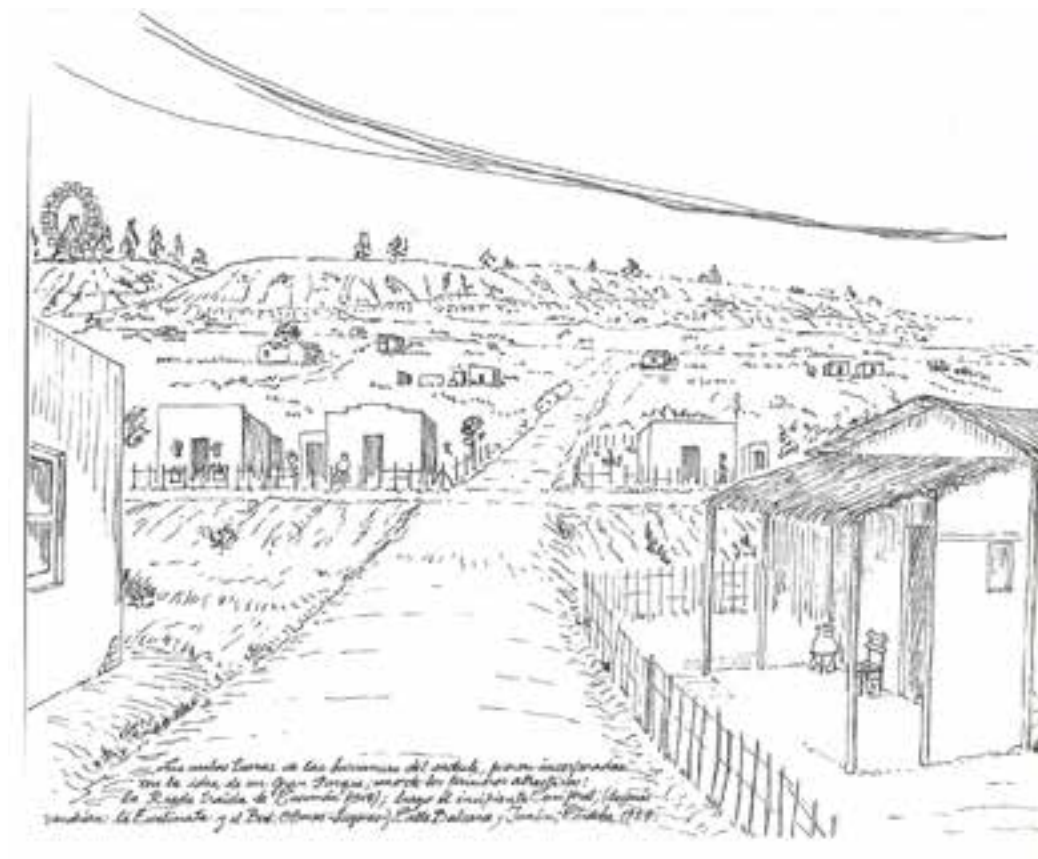
Perspectiva de la calle Balcarce hacia el sur, reconstrucción realizada por el Ing. Geólogo Ángel Alberto Díaz, material inédito.
